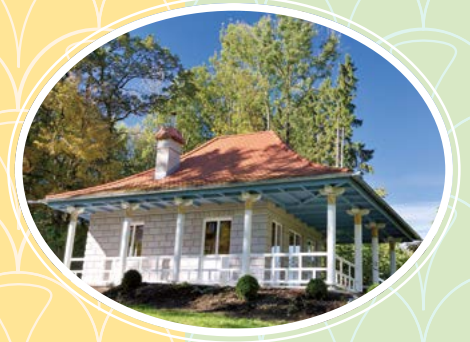
Das Teehaus von Julia und Ludwig von Schacky wurde mit großem Aufwand wieder in den ursprünglichen Zustand versetzt
